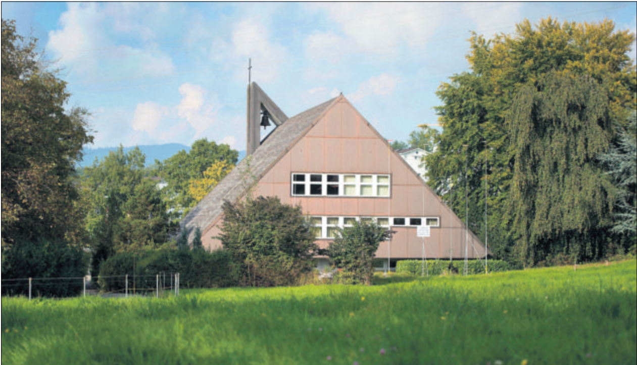
Statt Baumaschinen nur Bauprofile: Die Planungsarbeiten für den Ausbau der Kirche St. Thomas haben sich in die Länge gezogen.
